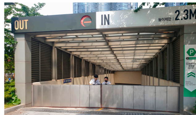
시설 안전 점검 현장
